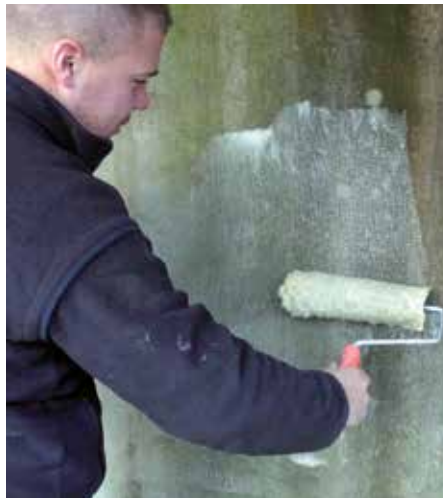
RÖFIX Algenkiller auftragen
