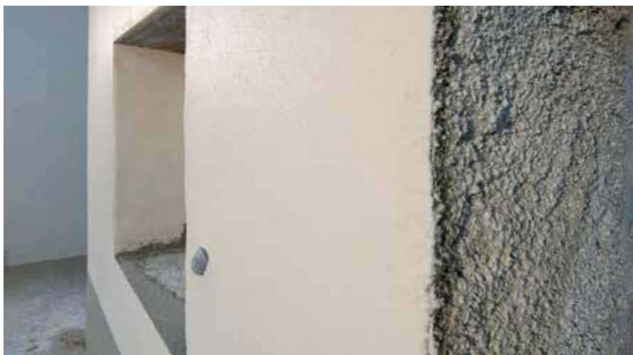
Aufbringen des Oberputzes (RÖFIX 380)
