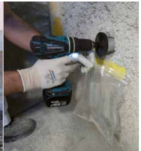
Putz auf Salzbelastung prüfen
