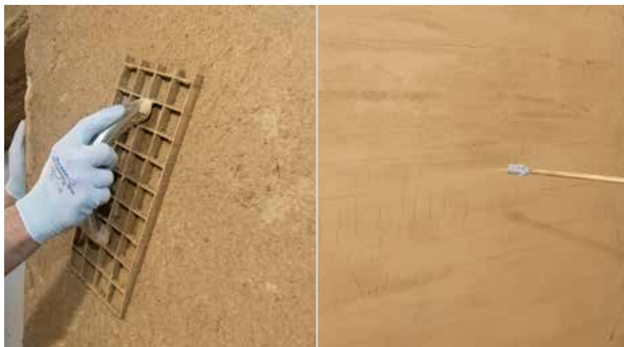
Plankratzen und vornässen von RÖFIX Geolehm®
