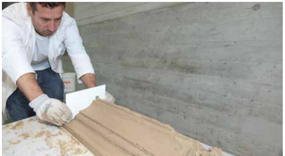
Abziehen von Zugprofilen mit Schablone
