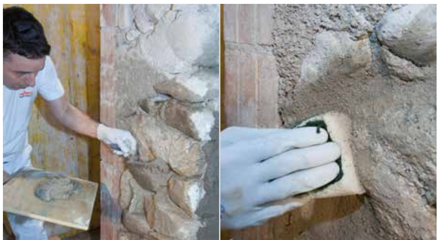
Natursteinmauerwerk ausfugen
