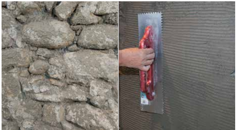
RÖFIX 671 Sanier-Vorspritzmörtel, 60 % deckend Aufbringen und kämmen des RÖFIX 648
