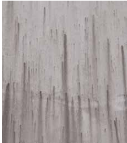
Algen-/pilzbefallener Fassadenputz
