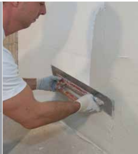
Armieren mit RÖFIX Renopor® Spezial-Klebspachtel
