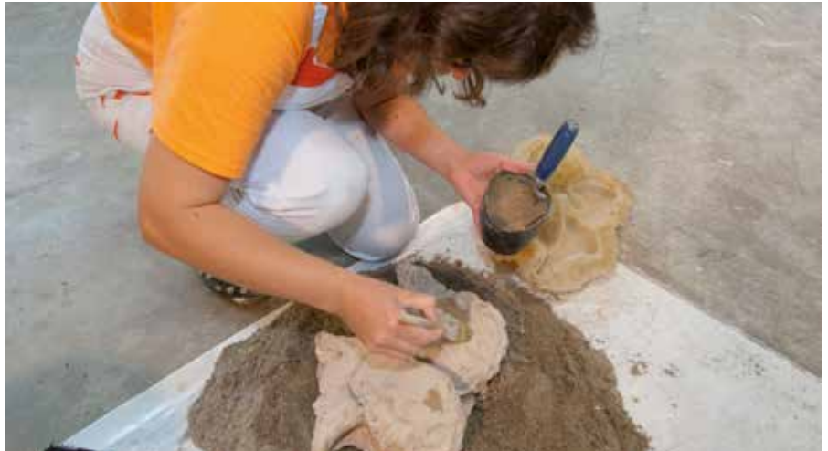
Überarbeiten von Gussteilen mit RÖFIX Belit Feinschlämme
