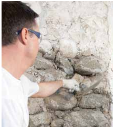
Anwurf mit RÖFIX 671 Sanier-Vorspritzmörtel, 60% deckend
