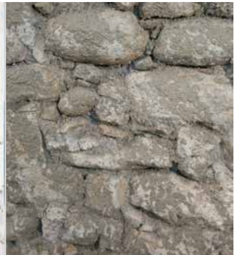
Stopfen/Anwerfen mit RÖFIX 648 Porengrundputz
