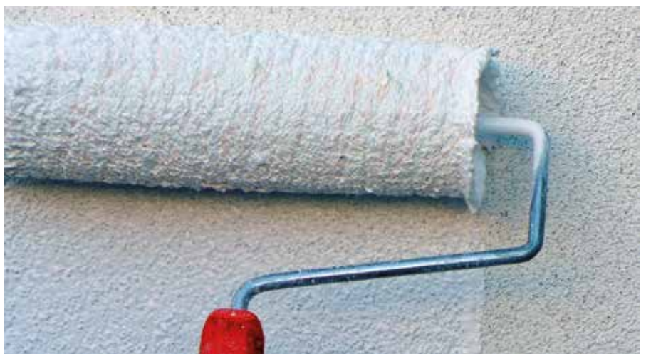
RÖFIX Fassadenfarbe auftragen
