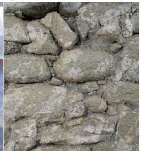
RÖFIX 671 Sanier-Vorspritzmörtel, 60% deckend
