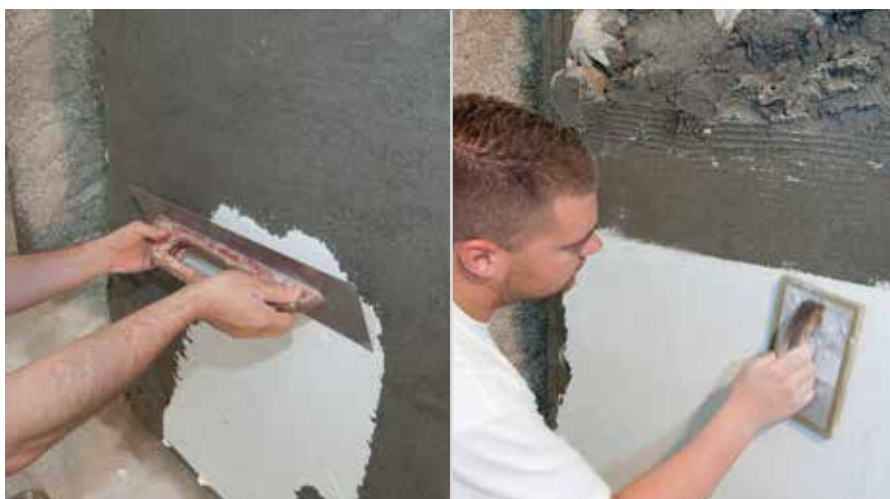
Aufziehen des RÖFIX 340/341
