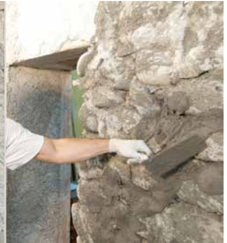
Stopfen/Anwerfen mit RÖFIX 648 Porengrundputz
