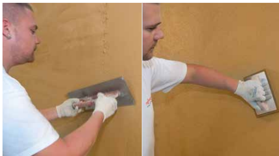
Auftrag der Feinputz-Schicht
