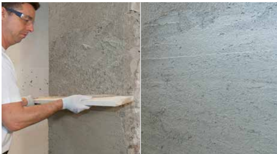
Abschweissen/Abziehen des Kalkputzes
