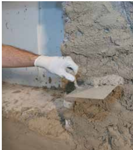
Auftragen des RÖFIX 697
