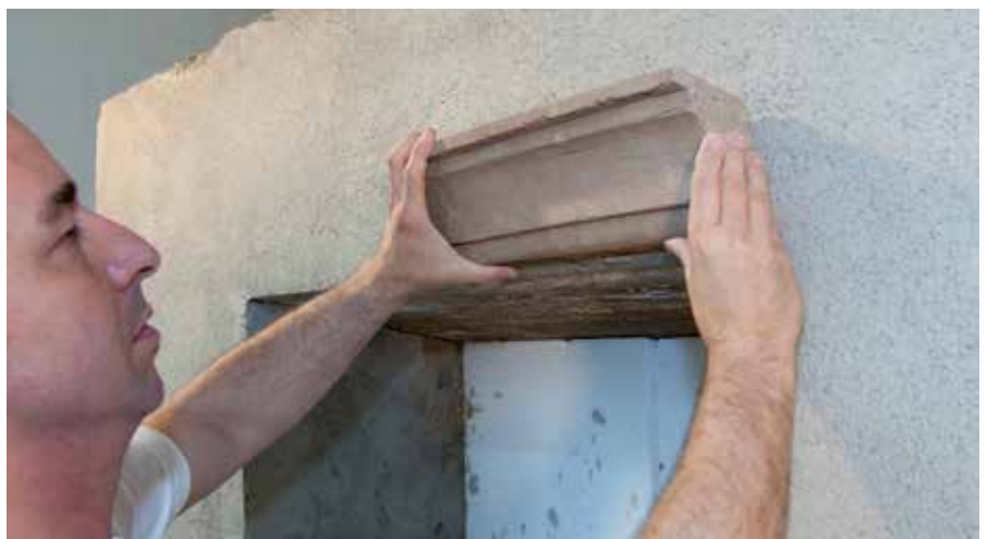
Montage von Dekorprofilen
