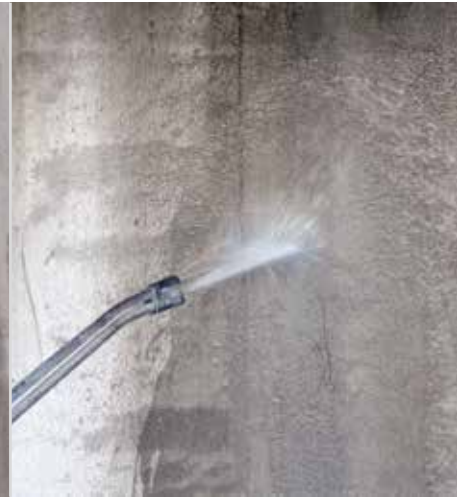
Fassadenputz nass reinigen
