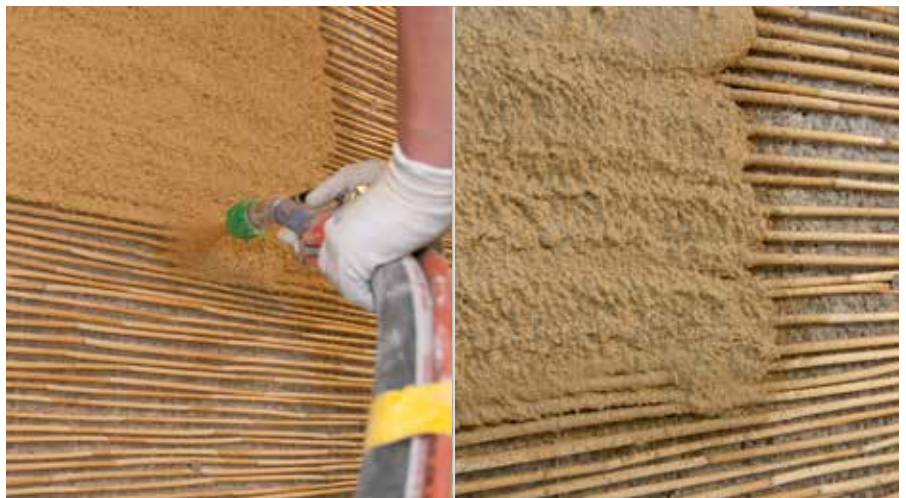
Auftragen von RÖFIX Geolehm®
