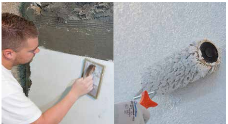
Abreiben und strukturieren des RÖFIX 340/341
