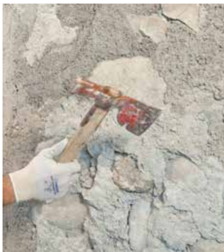
Abschlagen des Altputzes
