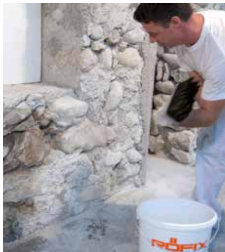
Anwurf RÖFIX Saniergrund mittels Malerbürste
